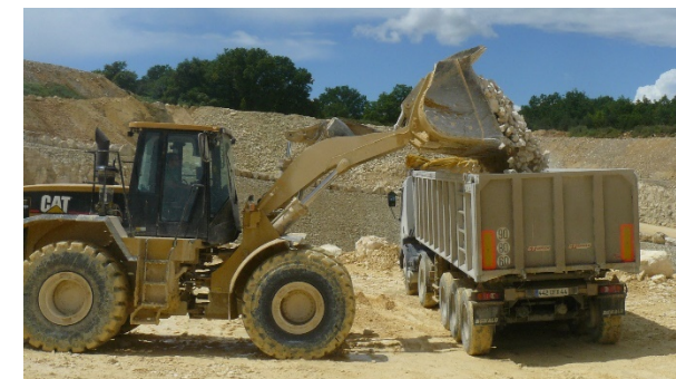
Le chargement d'un camion ▲
