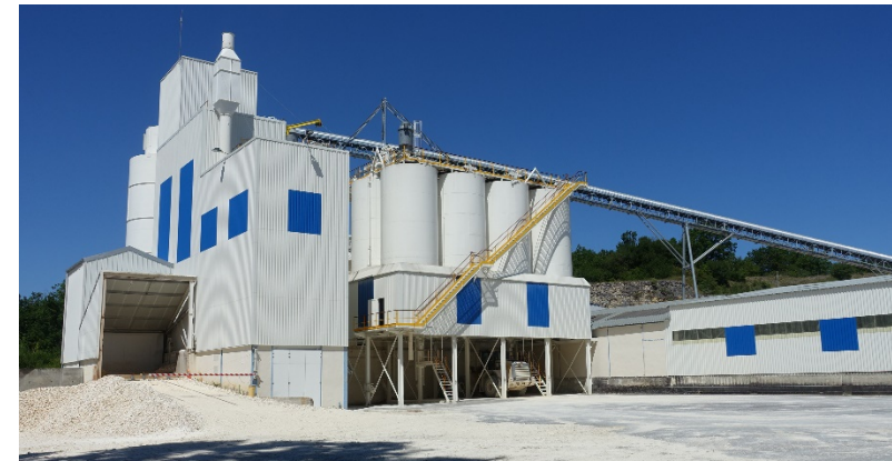
Usine de Bourg-des-Maisons ▲
